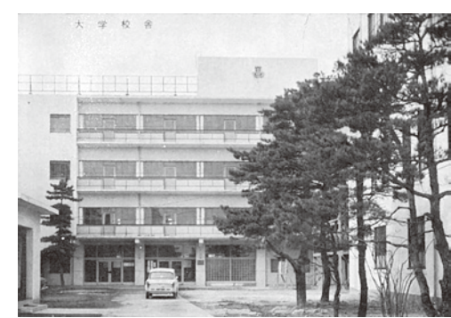
完成した鉄筋コンクリート4階建の第一号館
