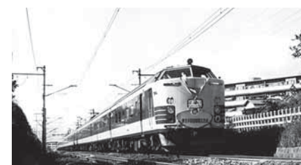
東北本線全線電化・複線化完成はつかり処女列車(仙台-長町間)
