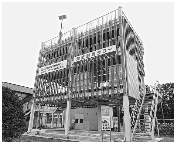
日鐵住金建材仙台製造所の津波避難タワー
